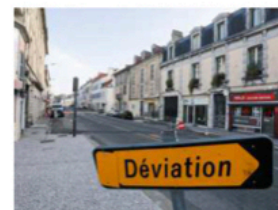
Au 14-Juillet, les travaux pèsent sur la fréquentation. © ASCENSION TORRENT
